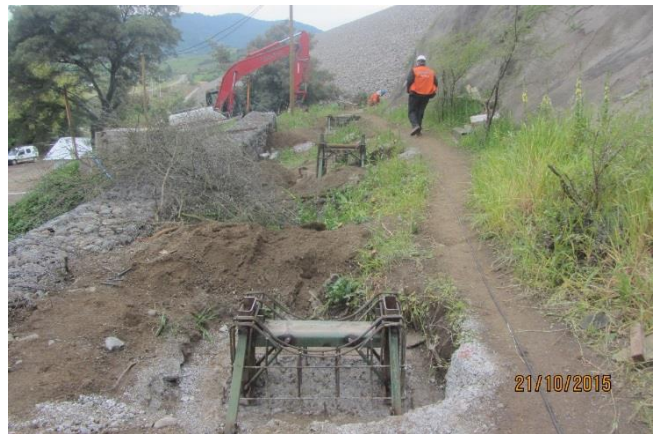
1ª Etapa de Hormigonado terminada, Machones M-12; M-11; M-10 y M-9.
