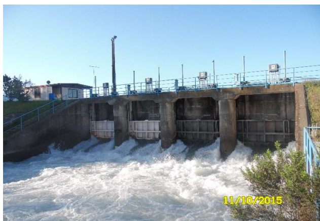
Bocatoma Canal Teno Chimbarongo
