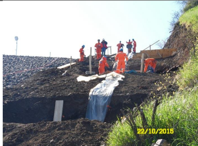
Hormigonado de Machones M-7 y M-8. Sifón Santa Adela.
