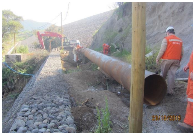
Spools N° 16 y 15 instalados sobre Machones M-12 al M-10.
