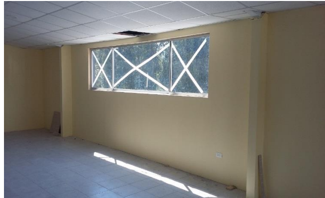
Casino Instalación de Faenas de la CHCV. Ventanas, Cielo Falso Americano y Cerámica en el piso.
